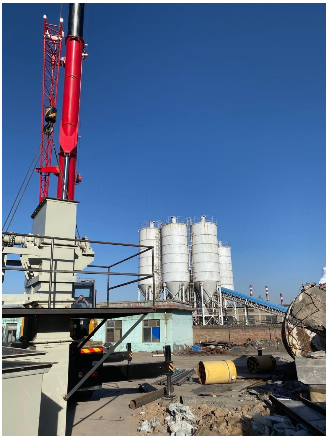
图5-1 NE 板链斗式提升机现场安装
